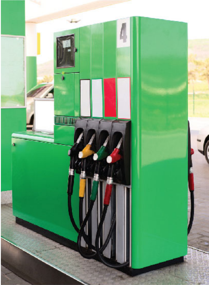
Estación de expendio de combustible
