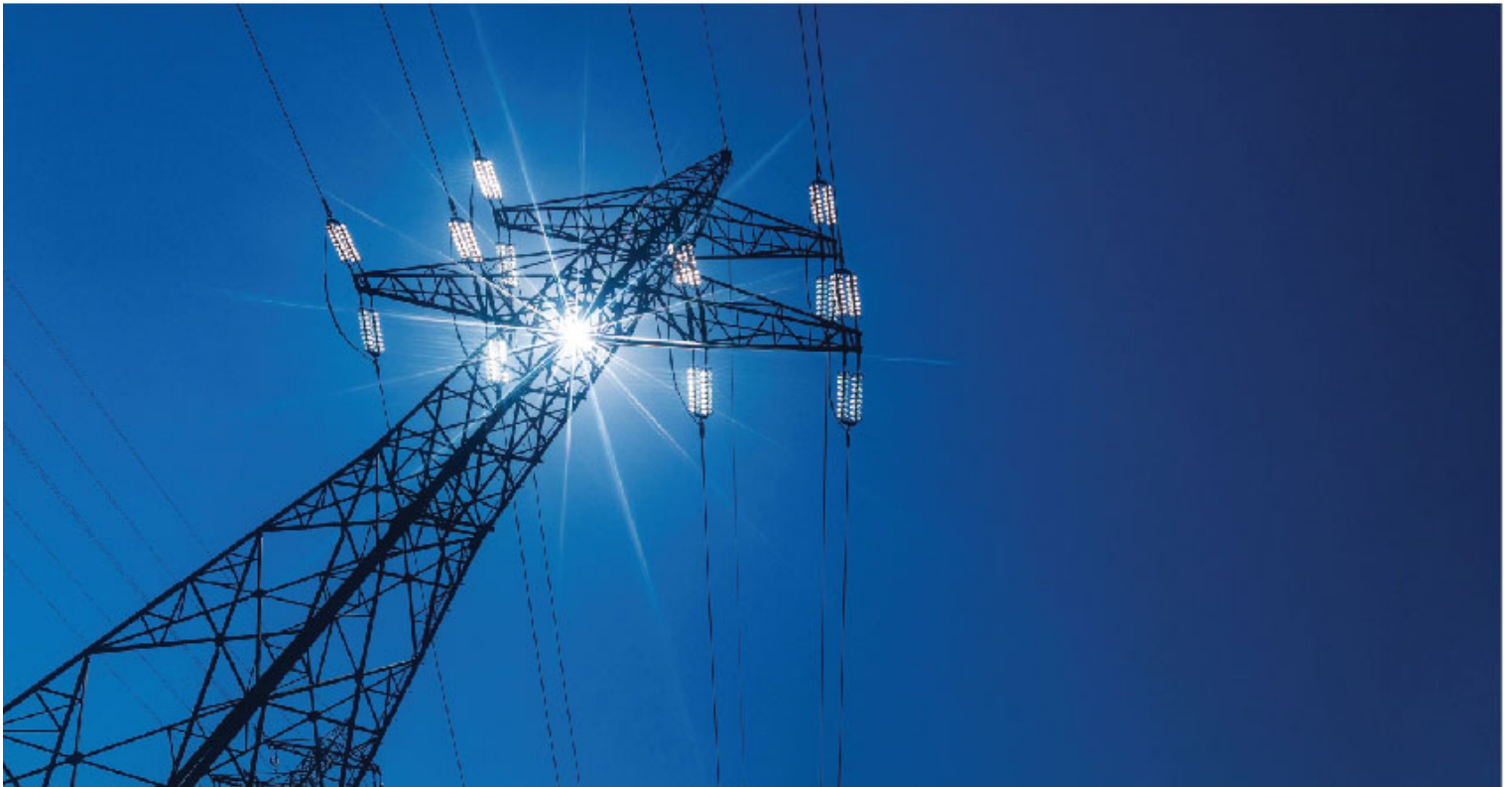
Torre de alta Tensión
