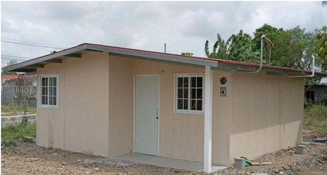
Casas con techos de zinc
