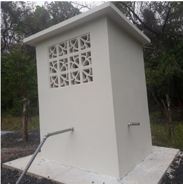
Acueducto de Los Montes
