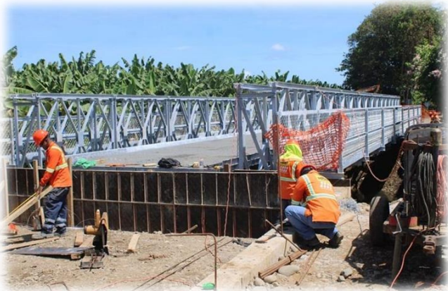
Construcción de Puente Modulares para el Progreso
