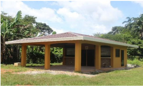
Instalaciones en el complejo deportivo Pedro Tuñón
