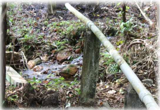
Acueducto Rural - distrito de Chimán
