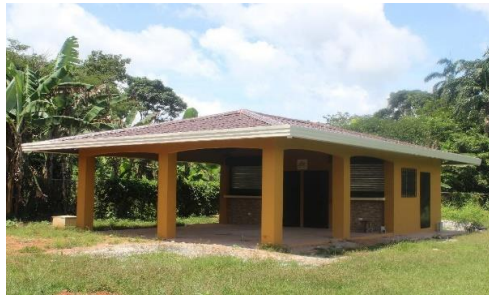
Instalaciones en el complejo deportivo Pedro Tuñón
