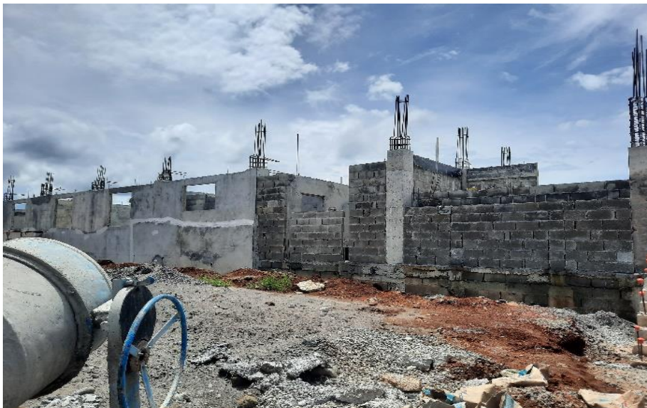
Construcción de la nueva sede del IPT Las Palmas
