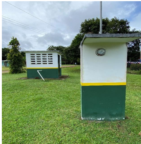
Acueducto de La Garceana
