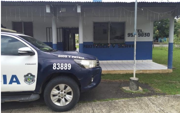
Sub-Estación del Corregimiento Calobre Cabecera
