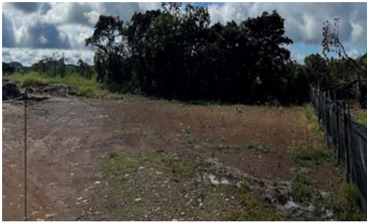
Vista noreste del vertedero municipal
