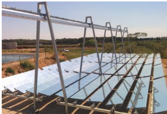
Figura 2. 9: Ejemplo de reflectores Fresnel
