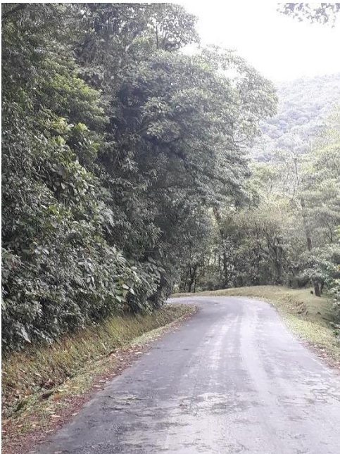
Foto 9. Tramo de carretera asfaltada (4km) que conduce a la entrada del sendero El Gaital, cerro Gaital. A. Delgado. 2017
