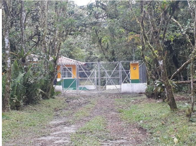
Foto 6. Caseta de entrada MIAMBIENTE. A. Delgado. 2017
