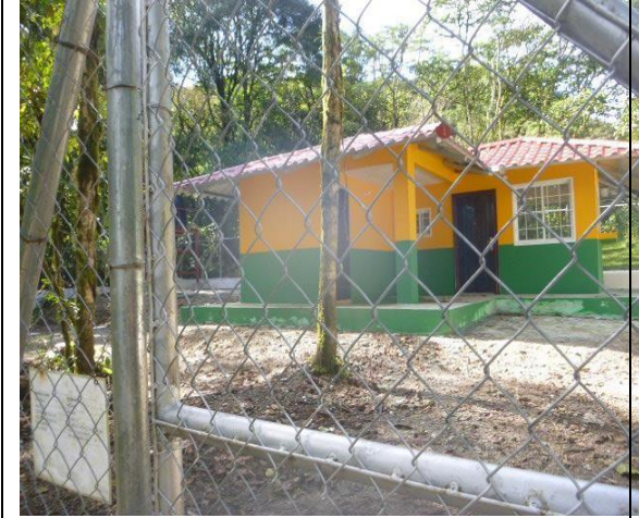
Foto 19. Caseta de entrada recientemente construida.
