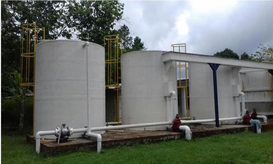
Vista de filtros floculador y sedimentador de la Potabilizadora de San Francisco
