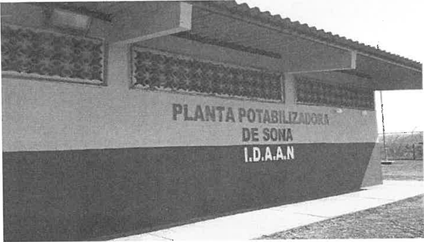
Instalaciones de la Potabilizadora
