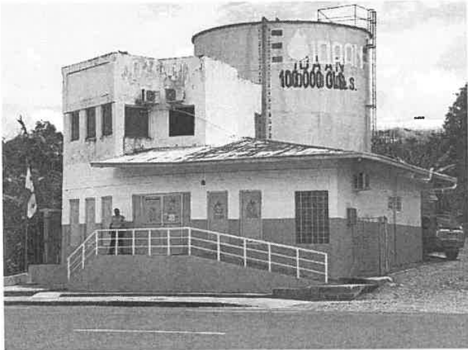
Tanque de almacenamiento en Soná
