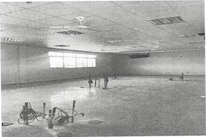
Construcción de la escuela Miguel Alba
