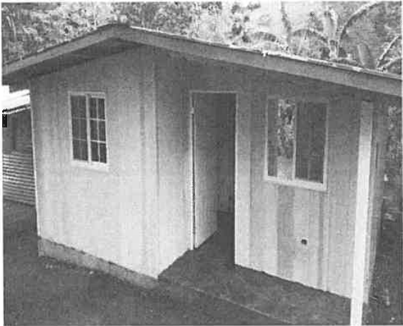
Vivienda con Techo de Zinc
