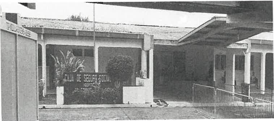
Hospital Ezequiel Abadía – Edificio antiguo
